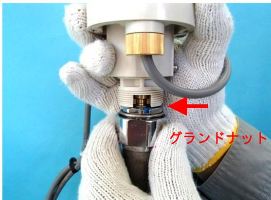
管吊式の場合、駆動部はグラウンドナットで固定されています。このグラウンドナットを緩めて外し、駆動部を交換して下さい。
